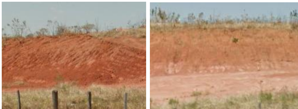
Imagem 8 e 9: Amostra de solo existente no trecho da duplicação. Fonte: Google Maps
